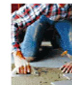
Die heute übliche Verlegetechnik im Dünnbett wurde durch Fliesenkleber mit VINNAPAS® erleichtert.
